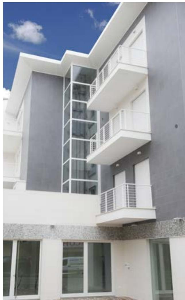
Installazione tipica di un ascensore con struttura esterna all'edificio in metallo e tamponamento in alluminio e cristallo trasparente.
