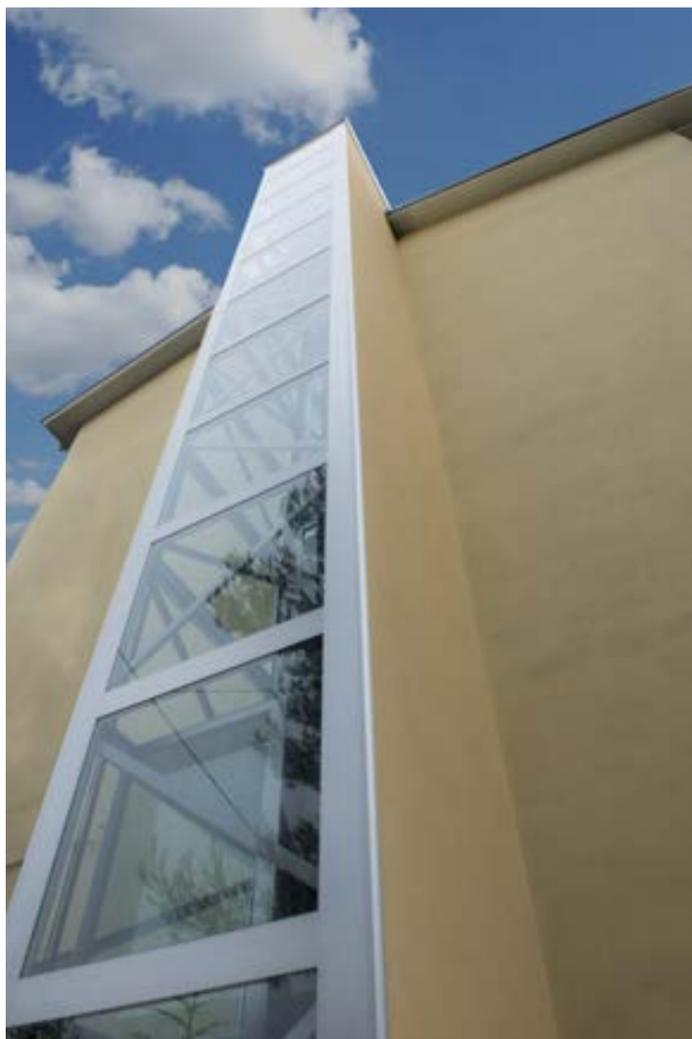
Installazione tipica di un ascensore esterno all'edificio con combinazione di tamponamenti in alluminio, vetro e cappotti termici certificati.
