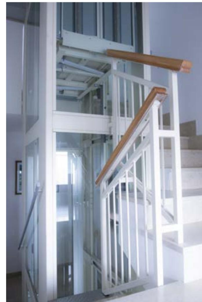
Installazione tipica di un ascensore interno all'edificio, ricavato nel vano scala con struttura in acciaio e tamponamento in cristallo.
