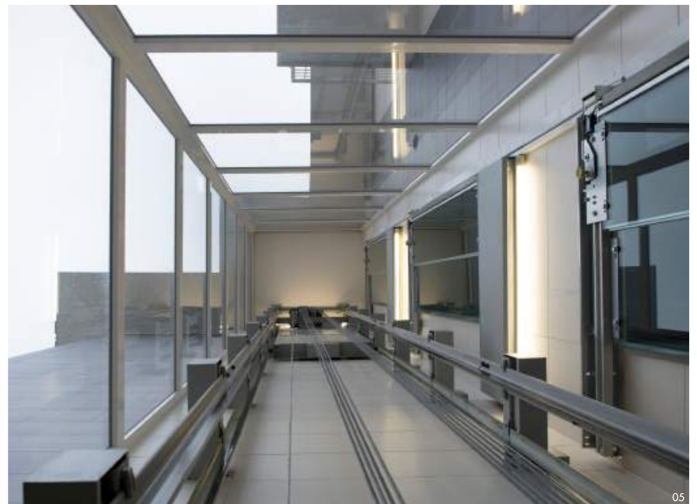
Installazione tipica di un ascensore esterno all'edificio con tamponamento in alluminio verniciato e vetro grigio europa.
